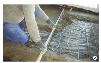
2. Cubrir con un polietileno de 100 micrones solapado >10 cm protegiendo todo la superficie de lana de vidrio (Panel PF y zócalo de lana de vidrio). Incorporar una malla de 10x10 Ø 4 mm instalada con separadores para que quede lo más centrada posible en la altura.
