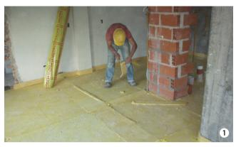
1. Colocar Panel PF cubriendo toda la superficie de la losa y los laterales conformando un zócalo con el mismo panel hasta la altura del nivel de piso terminado. Pegar dicho zócalo con adhesivo de contacto. En caso de requerir mayor espesor de Panel PF, instalar 2 capas desfasando las juntas de los paneles.
